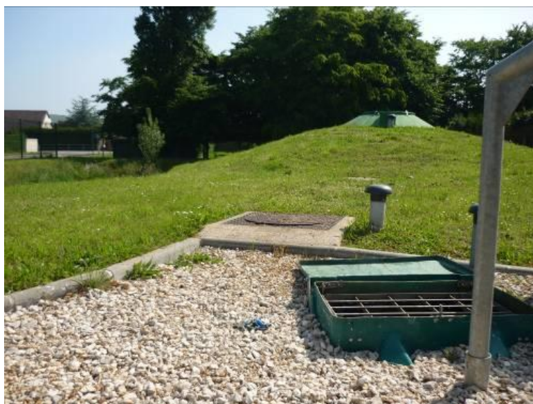
Vue sur la filière de traitement
