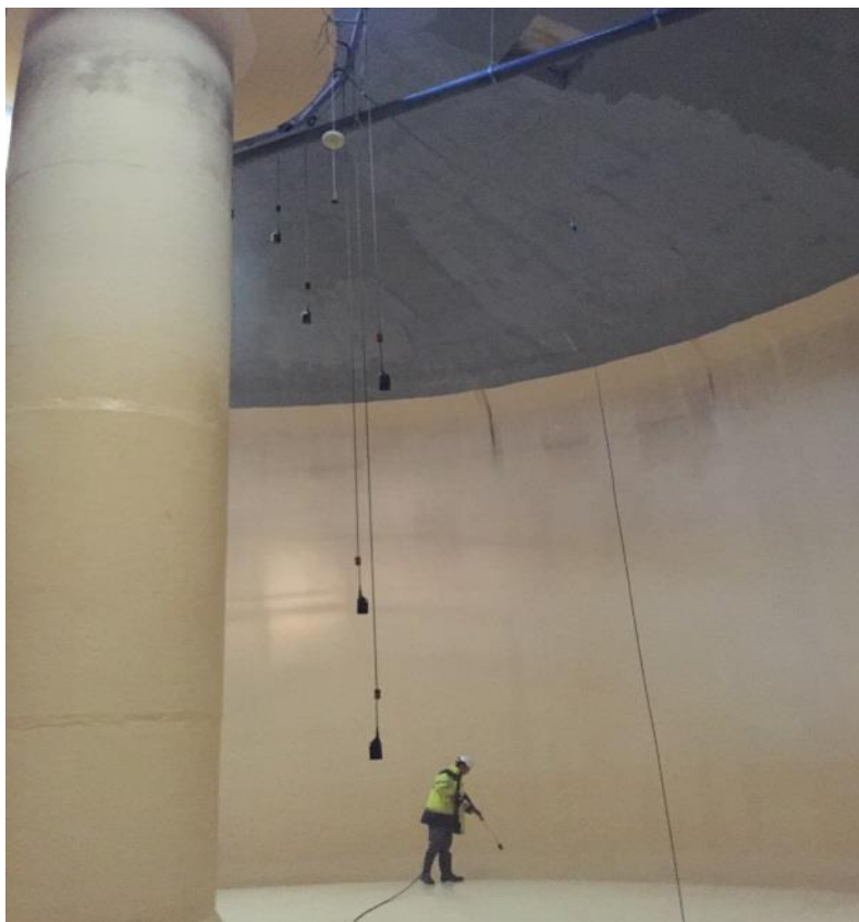
Nettoyage du réservoir de la Tremouille Evreux 3500 m 3
