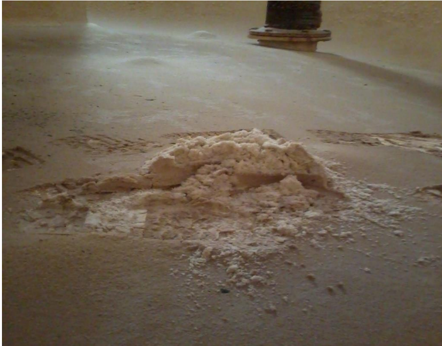
Etat d'une cuve avant lavage (Calcaire, sédiments)
