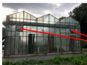
Condition 1 : Deux ventilateurs à l'arrêt et désodorisation en fonctionnement
