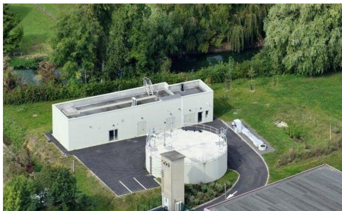
Vue générale du PR-BSR de Gravigny [façade est]
