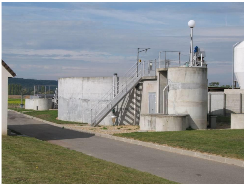
Vue d'ensemble de la station d'épuration
