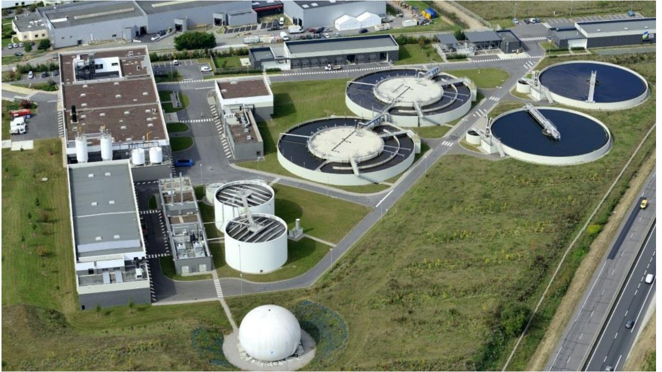
Vue générale du CTEU, (centre de traitement des eaux usée d'EPN à Gravigny), [axe est / ouest]
